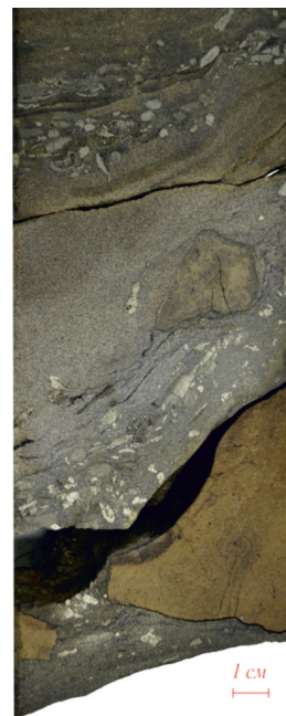
Фото 4. Крупные трещины в элювированных известняках турнейского яруса
